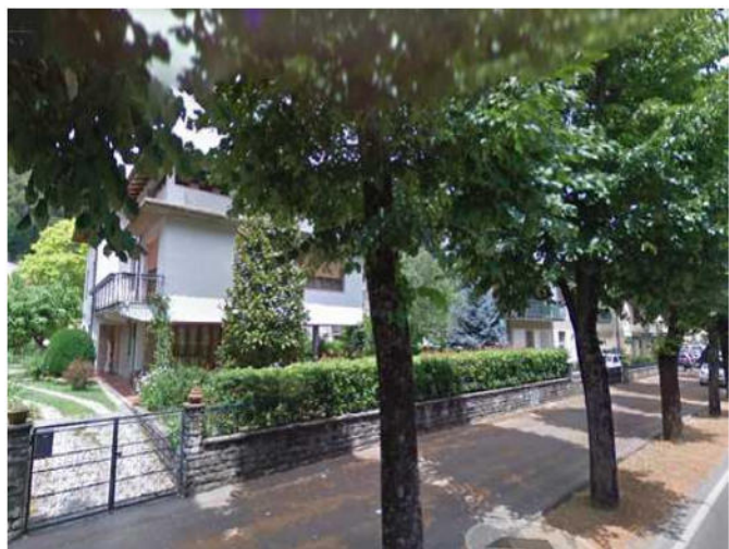
Prospetto su Via Provinciale
