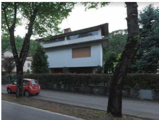
Prospetto su Via Provinciale
