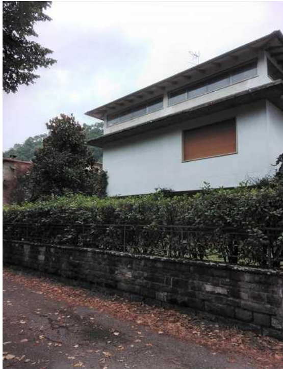
Prospetto su Via Provinciale
